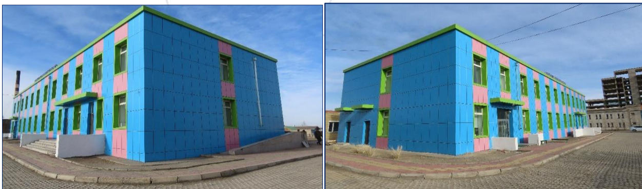
Зураг 3. Бүсийн оношилгоо эмчилгээний төвийн Халдвартын эмнэлгийн гадна фасадын засвар
