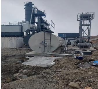
Тайлбар: СХД, “Асфальтын үйлдвэр барих, тоног төхөөрөмж нийлүүлэх ажил”, суурийн ажил төлөвлөөгүйгээс суурийн ажил ажил хийгдээгүй, стандартын дагуу гүйцэтгээгүй.
