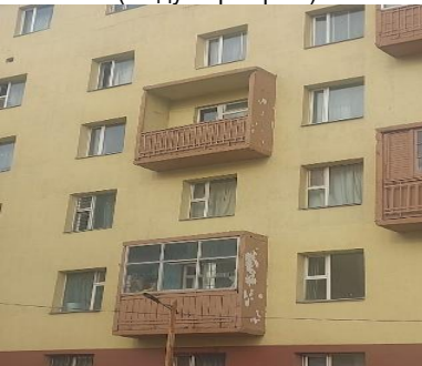
СХД, Байрны фасад засварын ажил, (20 дугаар хороо)
